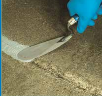
2 - Reparation af skader
